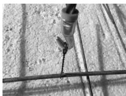
Sert à ligaturer sacs, clôtures et ferrailages pour béton armé.
